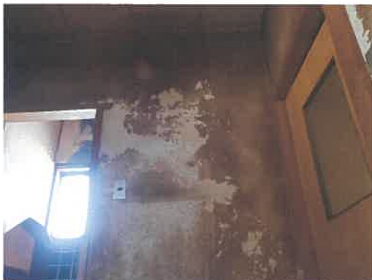
写真14 土壁の劣化
