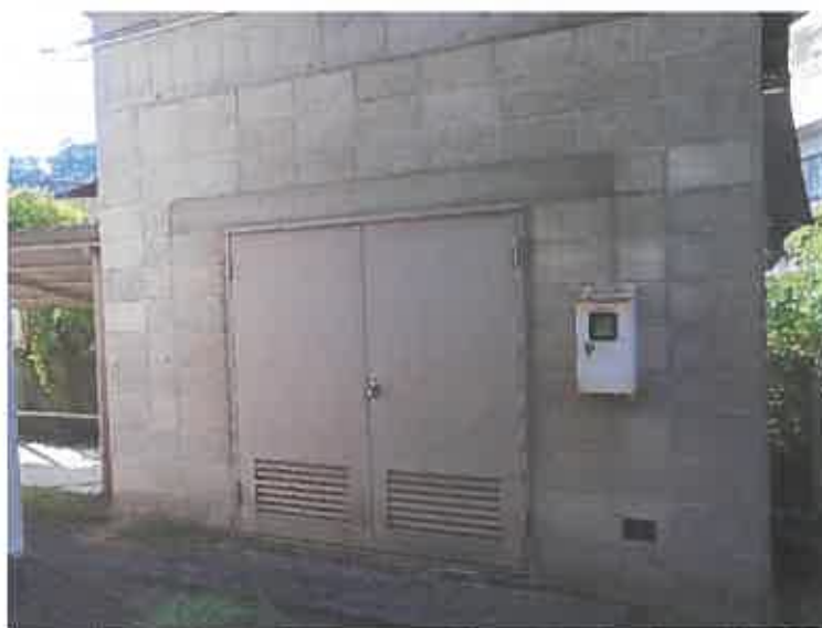
写真5 附属建物符号1 (機械室)
