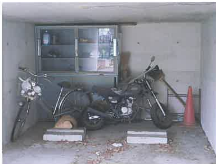
写真5 附属建物符号1 (掘込車庫)
