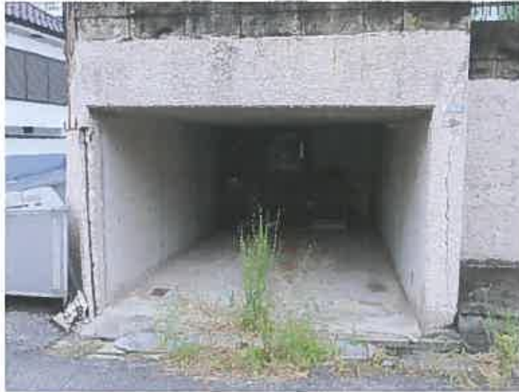
写真4 附属建物符号1 (掘込車庫)
