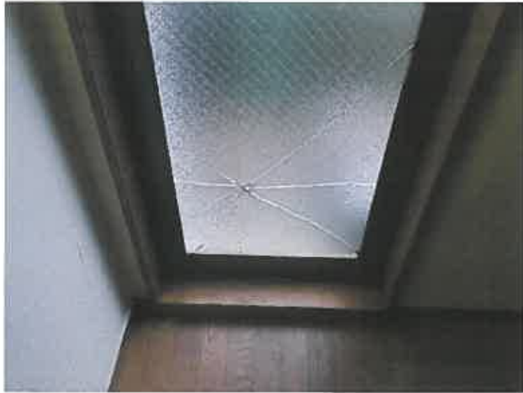
写真11 勝手口扉のガラス
