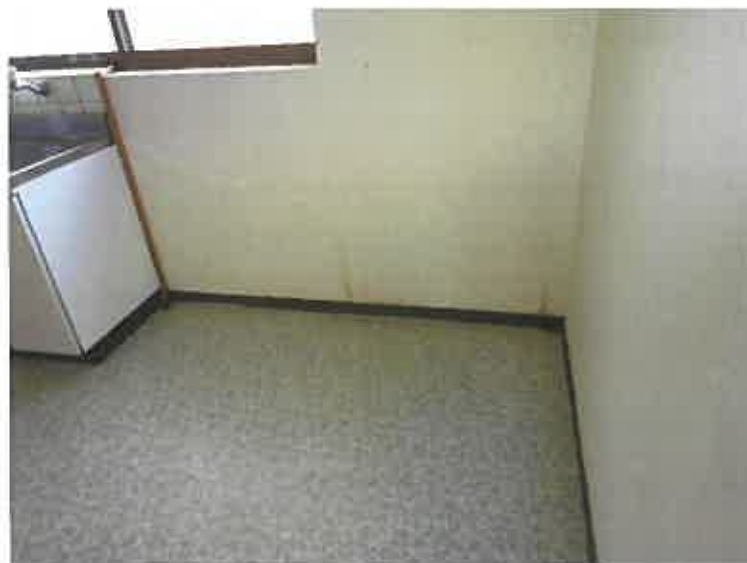
写真9 (本件建物(南東側) 1階)
