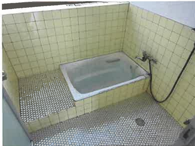
写真11 (本件建物(南東側) 1階)
