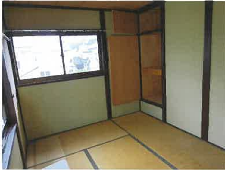
写真1 3 (本件建物(南東側) 2階)
