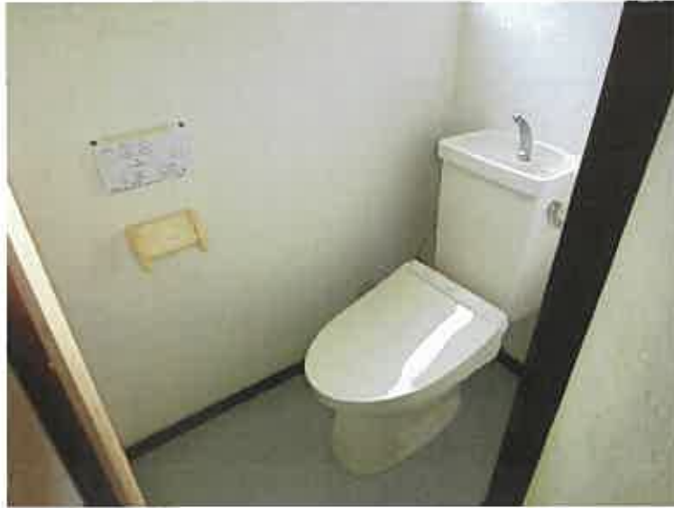
写真7 (本件建物(南東側) 1階)
