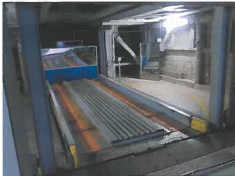
写真8 タワーパーキング内部の様子
