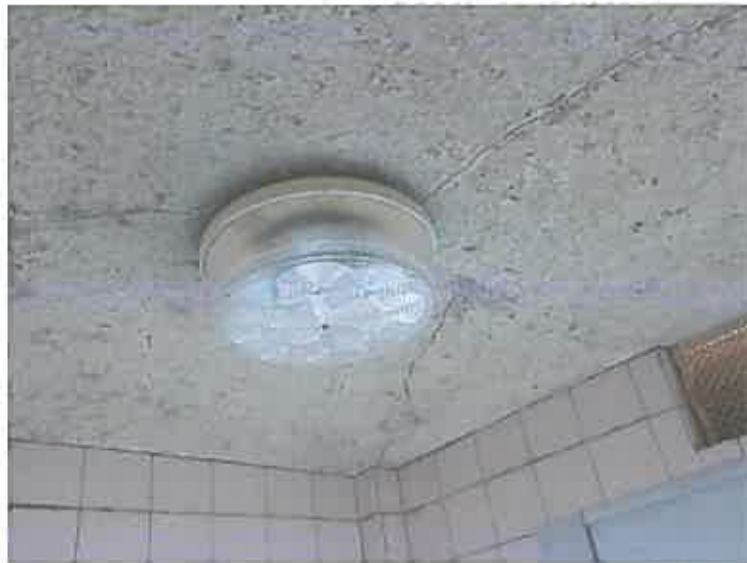
写真20 漏水箇所
