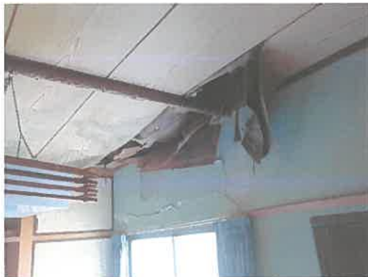
写真30 漏水箇所
