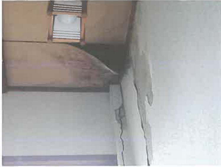
写真22 漏水箇所
