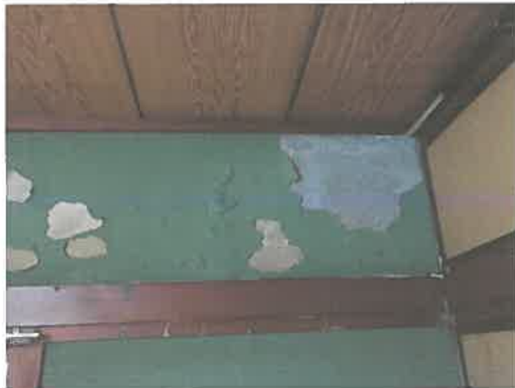
写真14 漏水箇所
