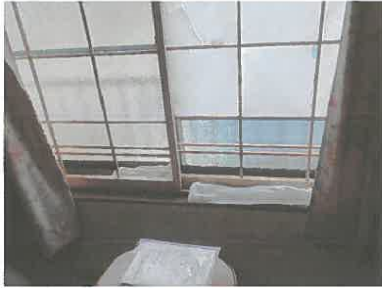
写真25 漏水箇所
