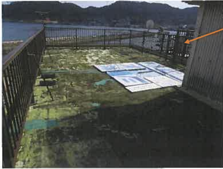
写真28 (物件2の建物 屋上)
