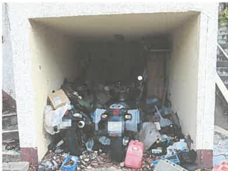
写真3 附属建物 (掘込車庫)
