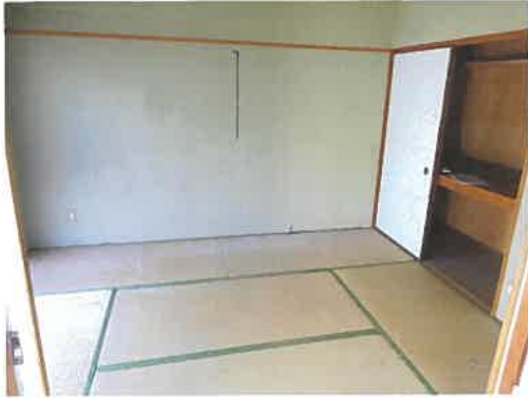
写真7 (本件建物 2階 (201号室))
