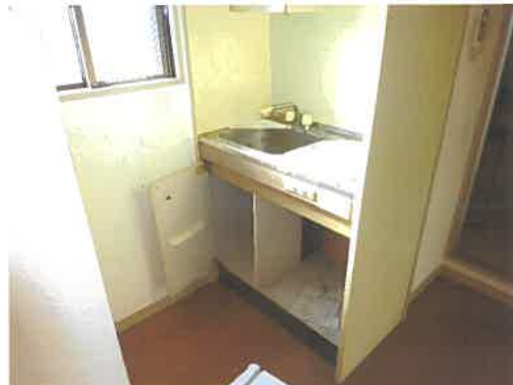
写真27 (本件建物 4階 (403号室))
