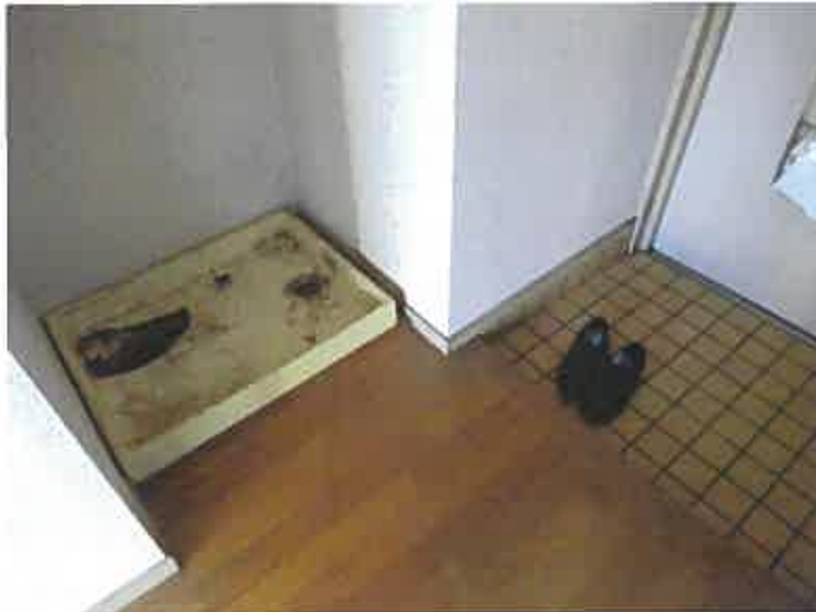
写真10 (本件建物 2階 (201号室))
