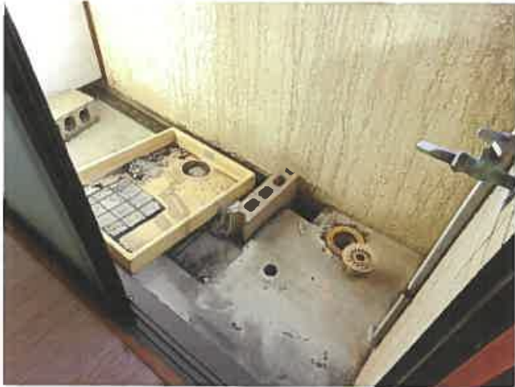
写真29 (本件建物 4階 (403号室))
