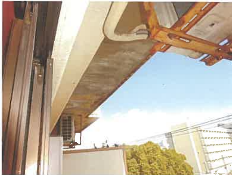
写真30 (本件建物 4階 (403号室))
