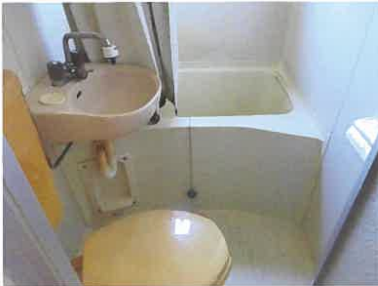
写真16 (本件建物 3階 (301号室))
