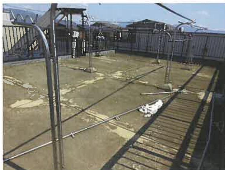
写真12 (本件建物 屋上)
