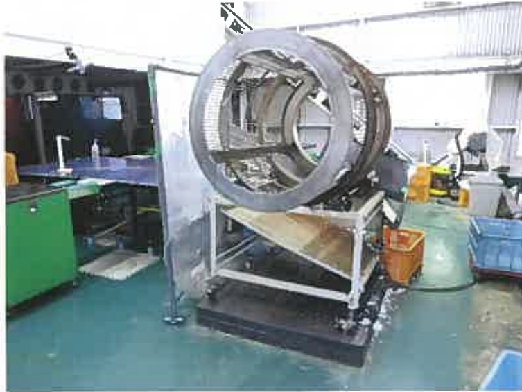
写真3 1(本件建物1階にある機械器具)
