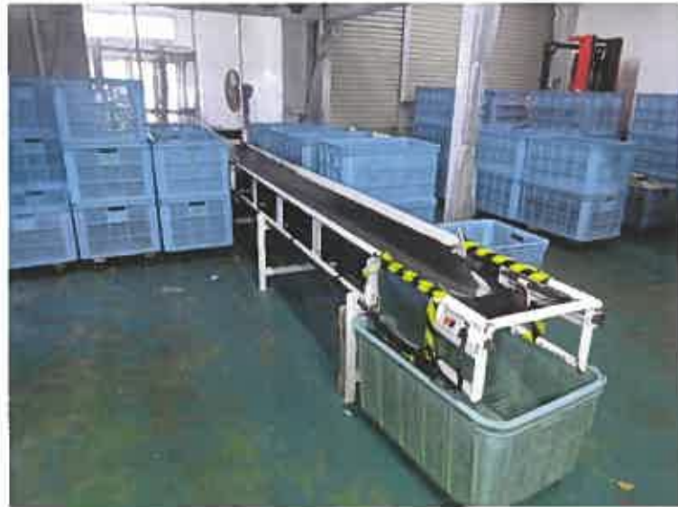
写真29(本件建物1階にあるベルトコンベア)
