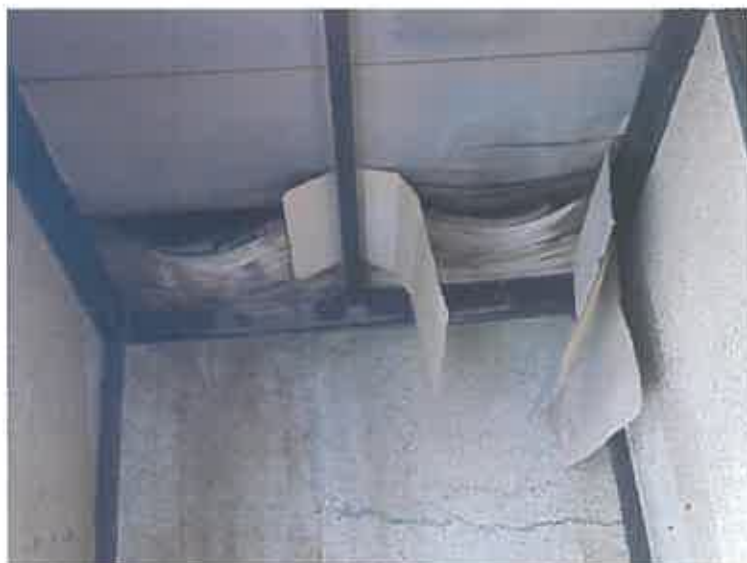
写真15 雨漏りの跡
