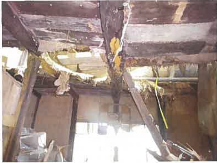
写真25(本件建物(附属建物符号3) 1階)
