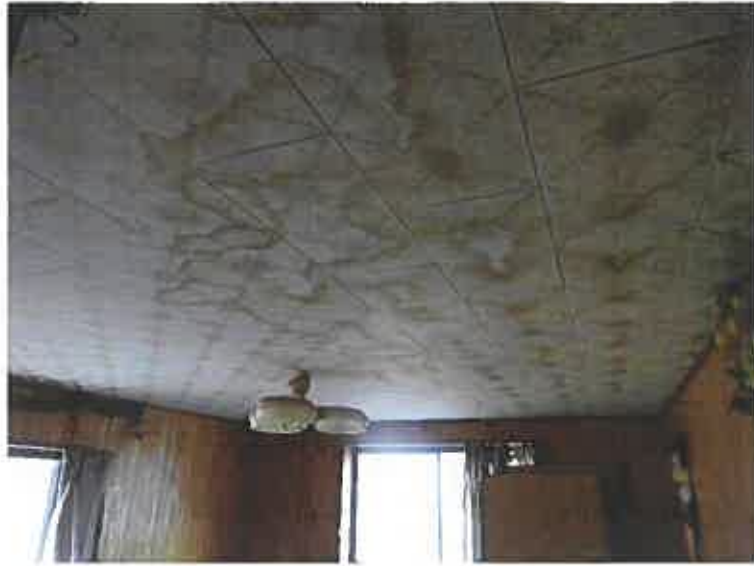
写真 2 2 (本件建物(附属建物符号 2) 2階)
