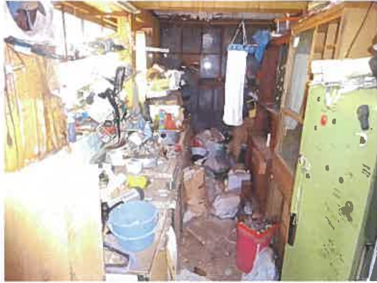
写真19(本件建物(附属建物符号2) 1階)
