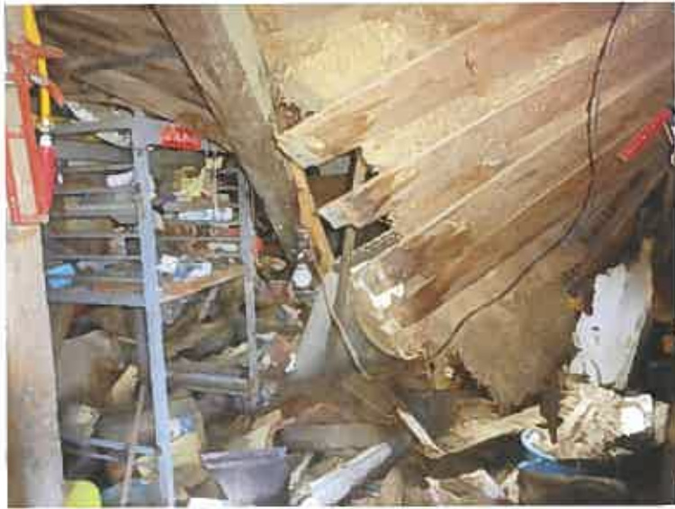
写真26(本件建物(附属建物符号3) 1階)
