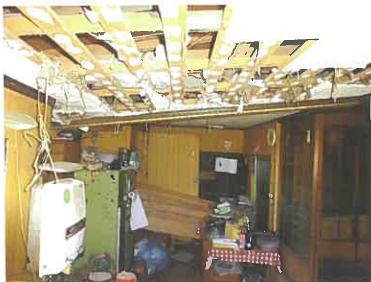
写真18(本件建物(主建物) 1階)
