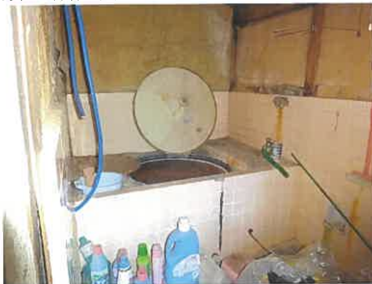
写真16(本件建物(主建物) 1階)
