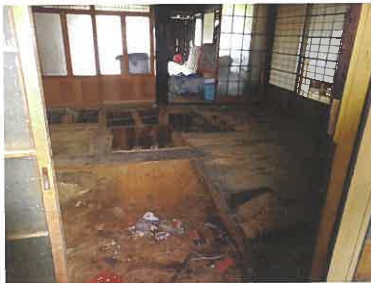
写真14(本件建物(主建物) 1階)
