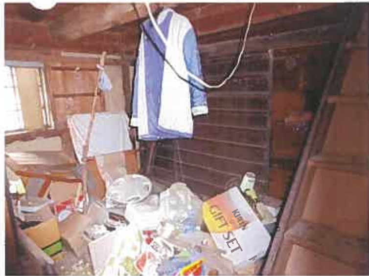
写真20(本件建物(附属建物符号2) 1階)
