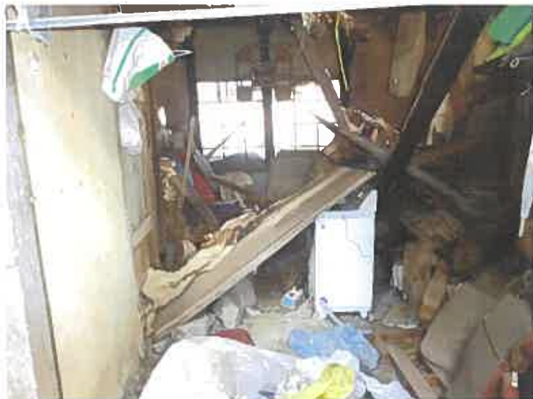
写真 2 4 (本件建物(附属建物符号 3) 1階)
