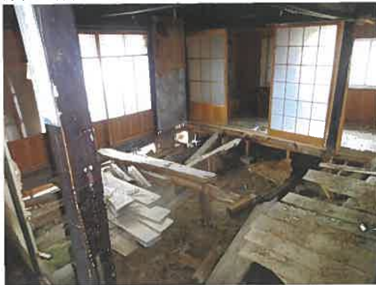
写真13(本件建物(主建物) 1階)
