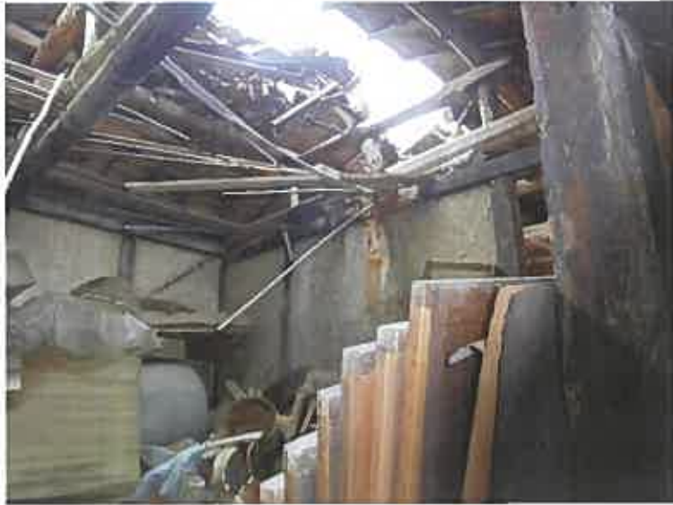
写真28(本件建物(附属建物符号3) 2階)
