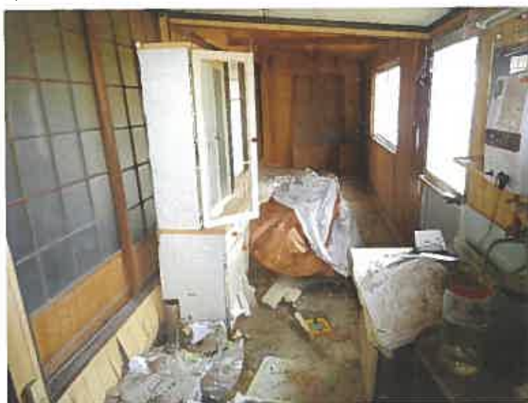
写真17(本件建物(主建物) 1階)
