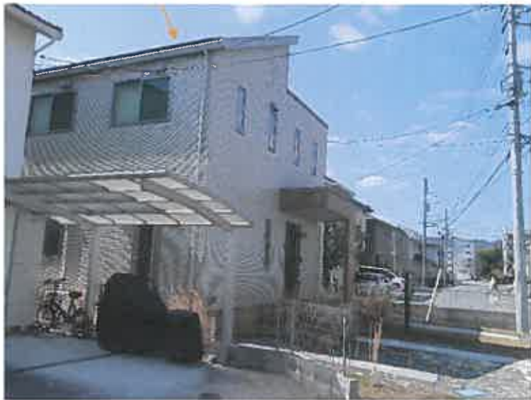
写真2 太陽光発電設備（ソーラーパネル）
