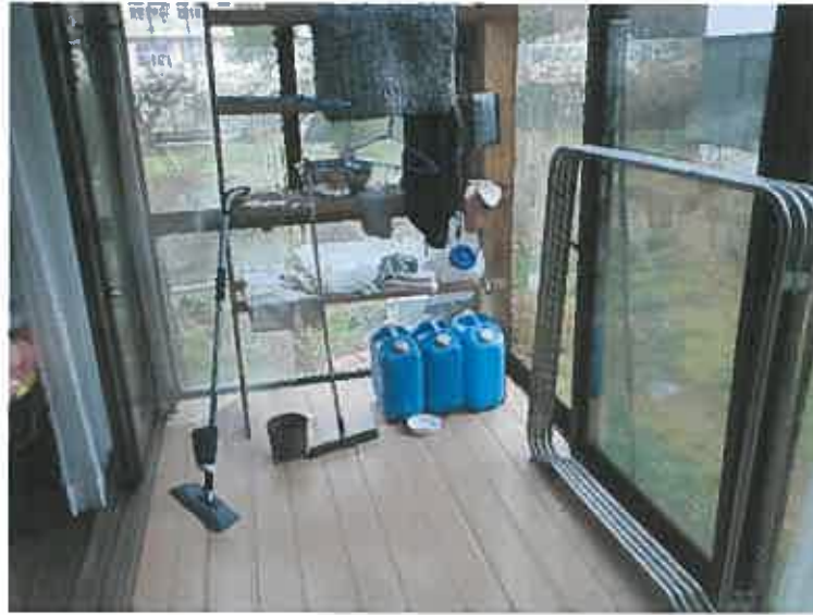
写真19 物件8建物未登記増築部分（サンルーム）
