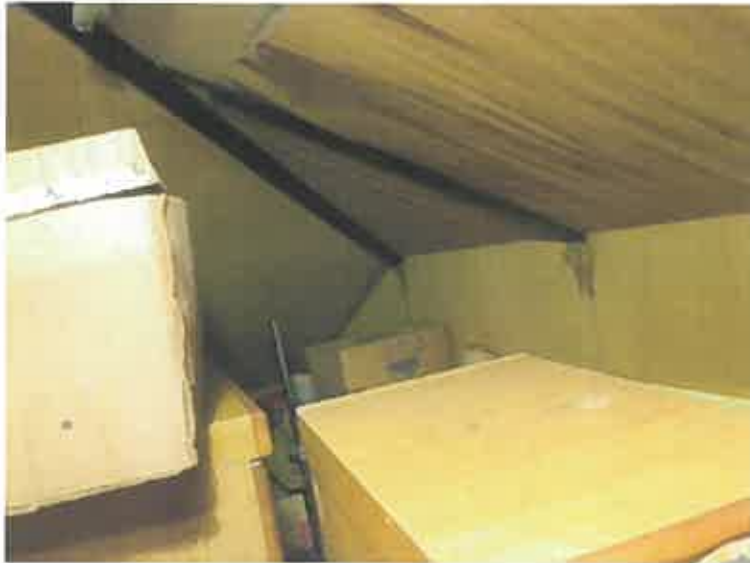
写真3 2 物件8建物（屋根裏収納内部の様子）
