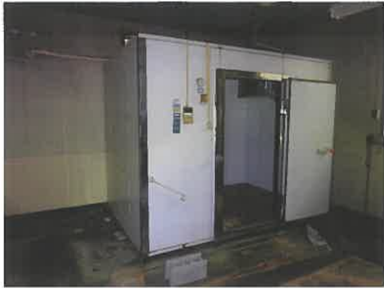
写真5 2 (本件建物内にある写真1 7の冷蔵庫)
