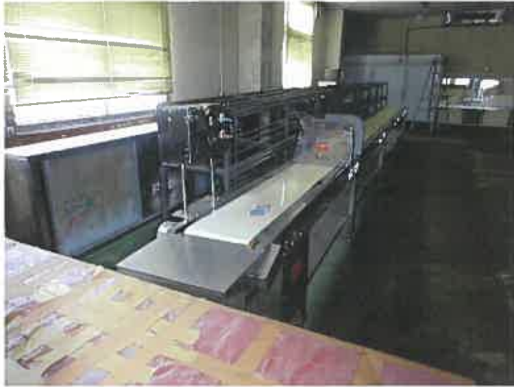
写真43 (本件建物内にある写真11、12のコンベアー)
