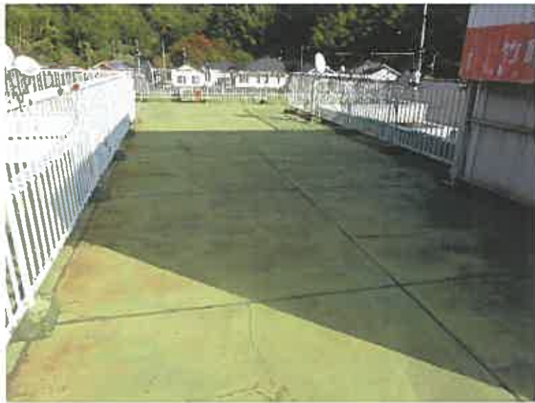
写真38 (本件建物 屋上)
