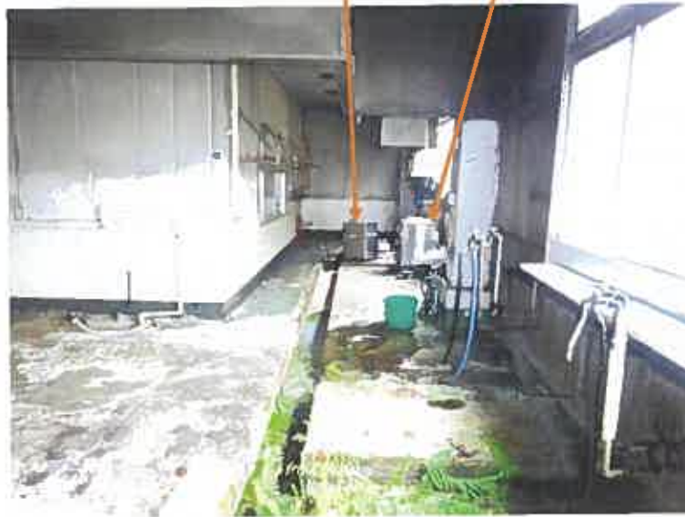
写真16 (本件建物 1階) 盛付器 洗米機
