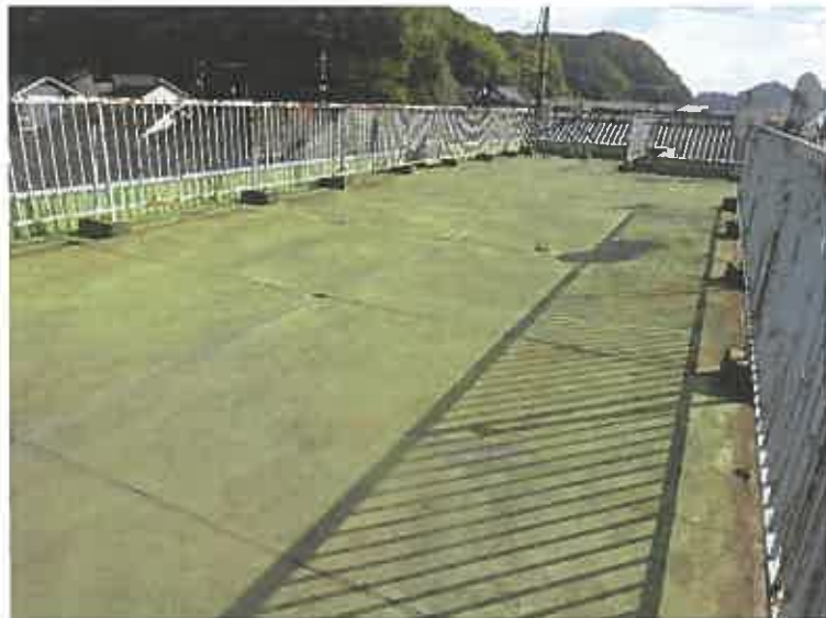
写真39 (本件建物 屋上)
