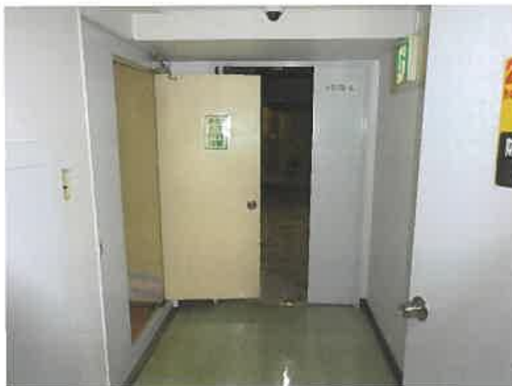
写真1 5 (本件マンション1階にある本件建物(附属建物)へ通じるトランクルーム入り口付近の状況)
