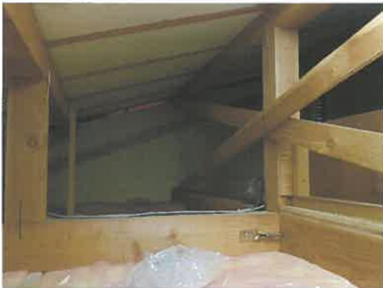
写真11 屋根裏の様子
