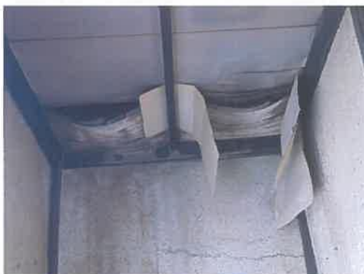
写真15 雨漏りの跡
