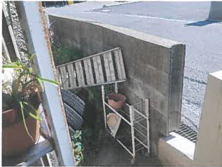
写真4 コンクリートブロック塀
