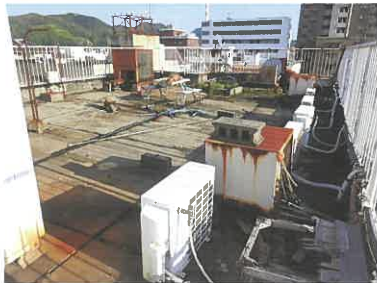
写真 2 7 (本件建物 屋上 (北西端付近から南東側方向を撮影))
