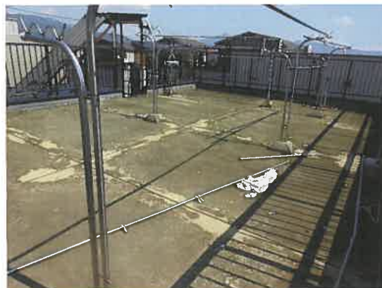
写真12 (本件建物 屋上)
