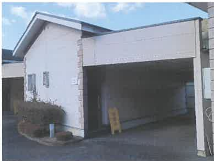
写真 8 4 物件 5 建物附属建物符号 1 2 (103号室)
