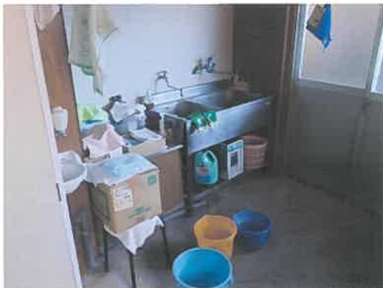
写真1 5 物件5建物（主たる建物・事務所）
