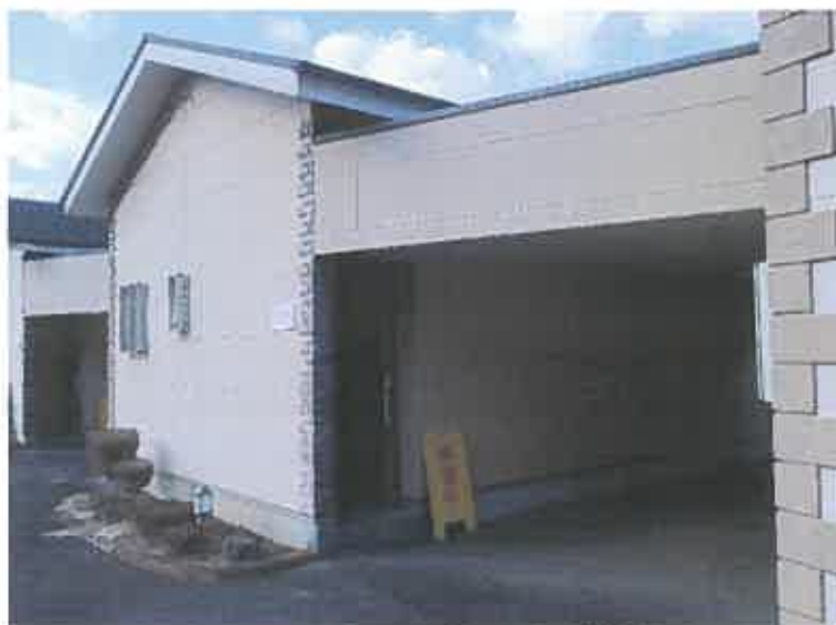
写真60 物件5建物附属建物符号7 (105号室)
