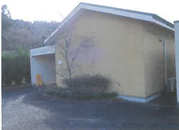
写真3 3 物件5建物附属建物符号3 (1 1 3号室)
