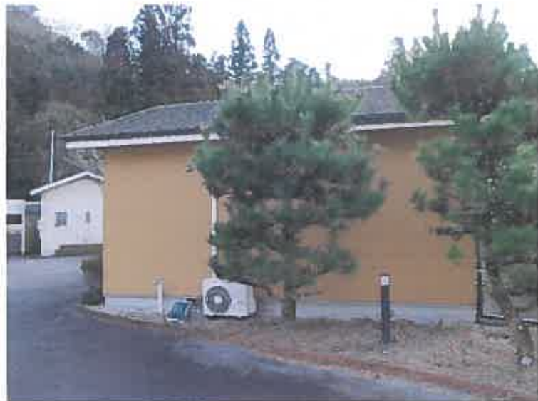
写真41 物件5建物附属建物符号4 (112号室)
