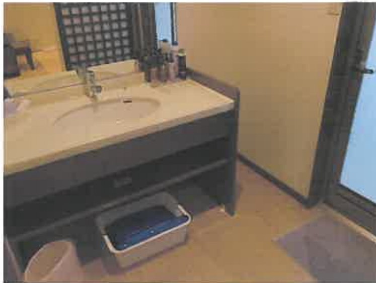
写真46 物件5建物附属建物符号4（112号室）
