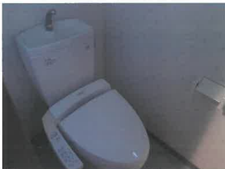
写真26 物件5建物附属建物符号1 (116号室)
