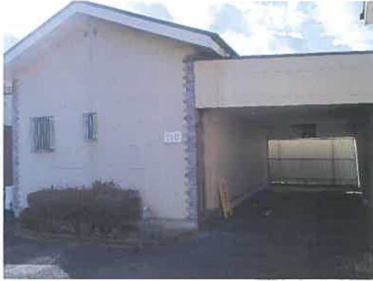
写真55 物件5建物附属建物符号6 (110号室)
