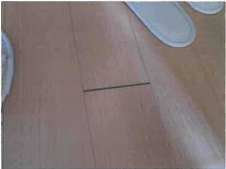
写真72 物件5建物附属建物符号9 (107号室)
