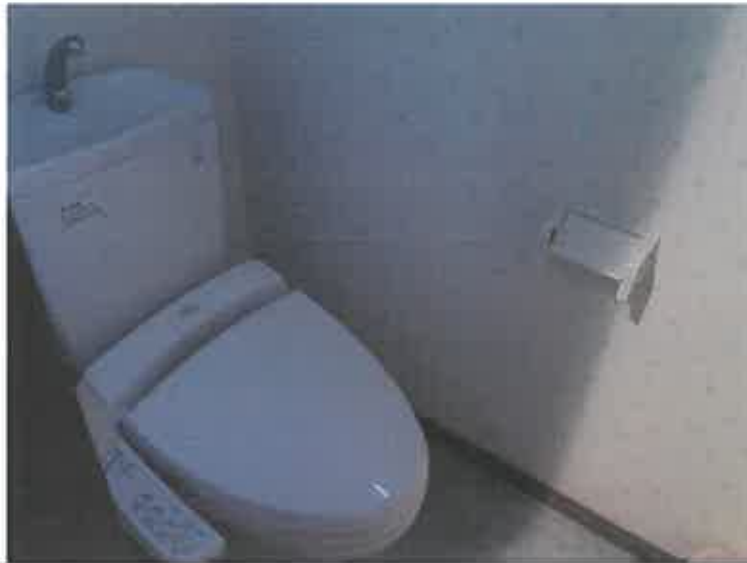
写真3 1 物件5建物附属建物符号2 (1 1 5号室)
