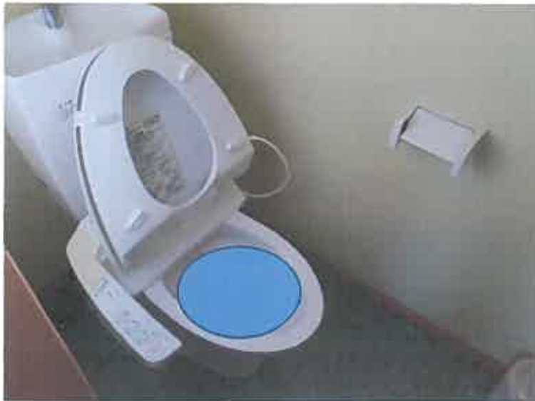
写真7 4 物件5建物附属建物符号9 (107号室)
