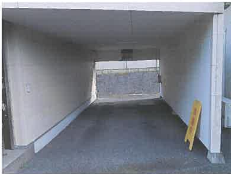
写真21 物件5建物附属建物符号1（116号室）
