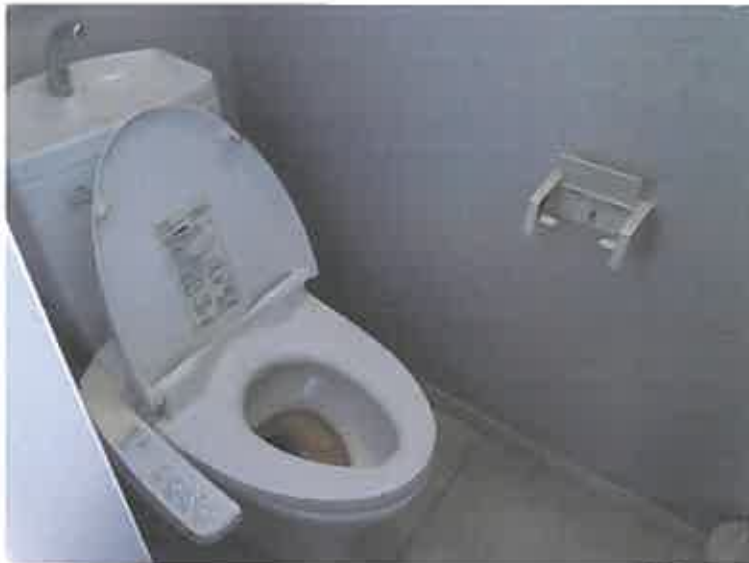
写真9 2 物件5建物附属建物符号1 3 (1 0 2号室)
