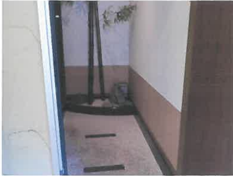
写真3 4 物件5建物附属建物符号3 (1 1 3号室)
