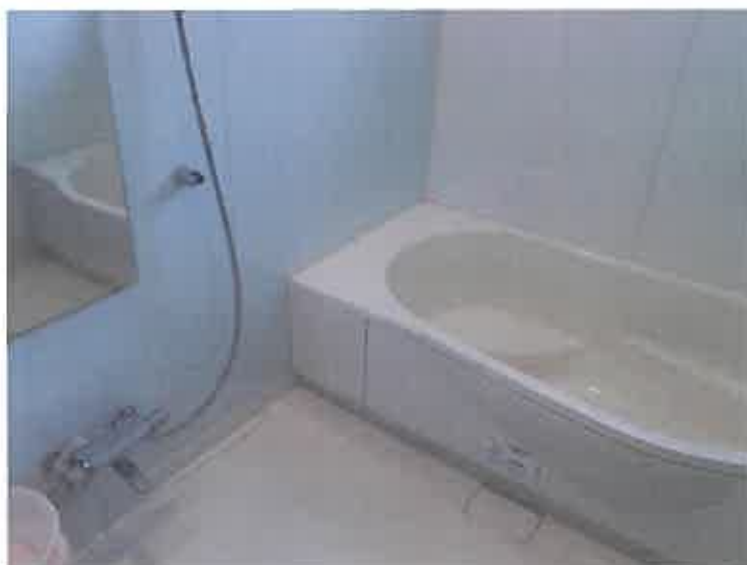
写真48 物件5建物附属建物符号4（112号室）
