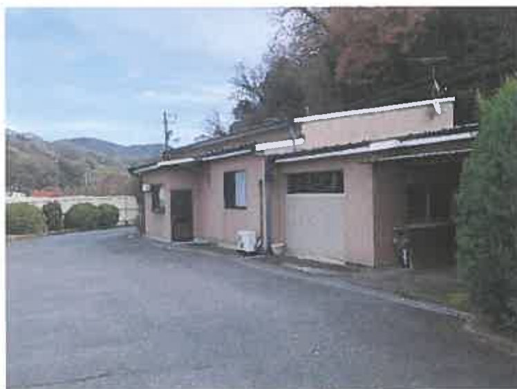
写真 3 物件 5 建物（主たる建物・事務所）
