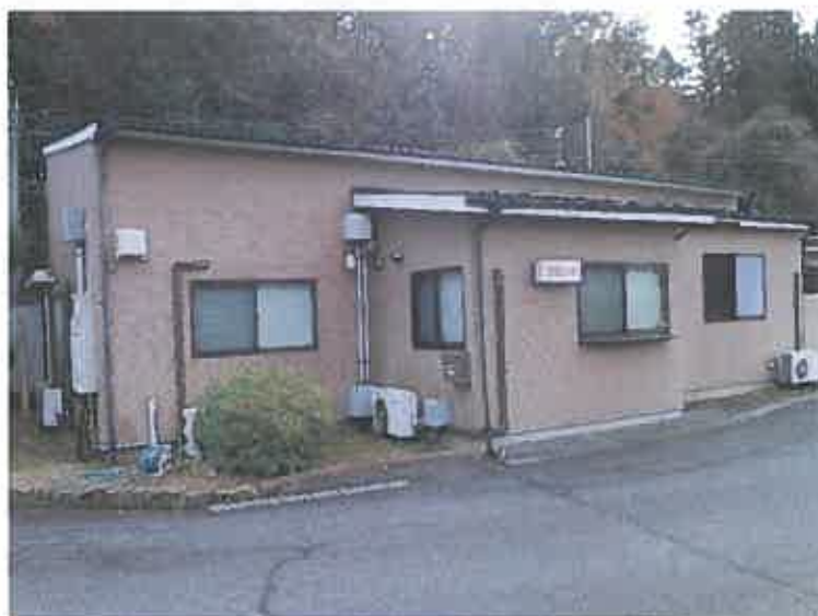
写真 2 物件 5 建物（主たる建物・事務所）
