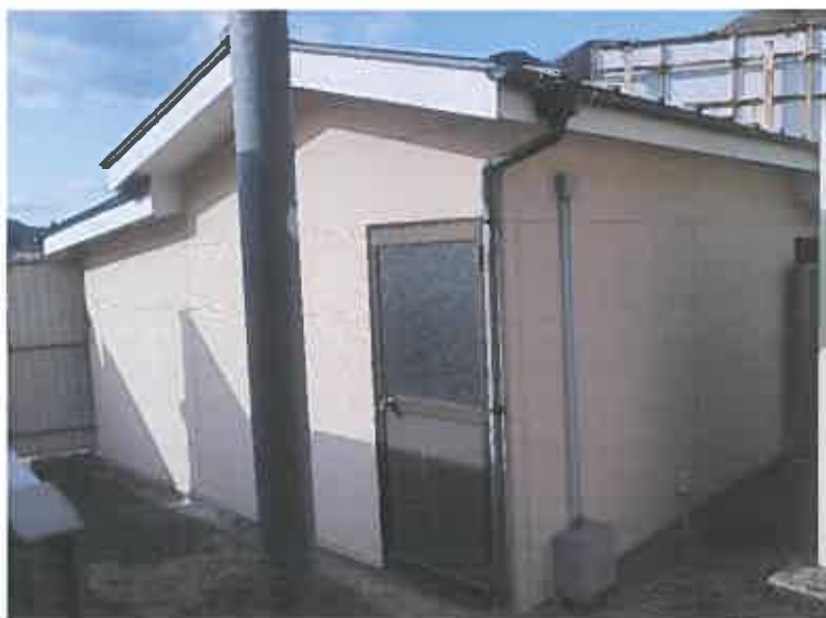
写真 8 1 物件 5 建物附属建物符号 1 1 (機械室)
