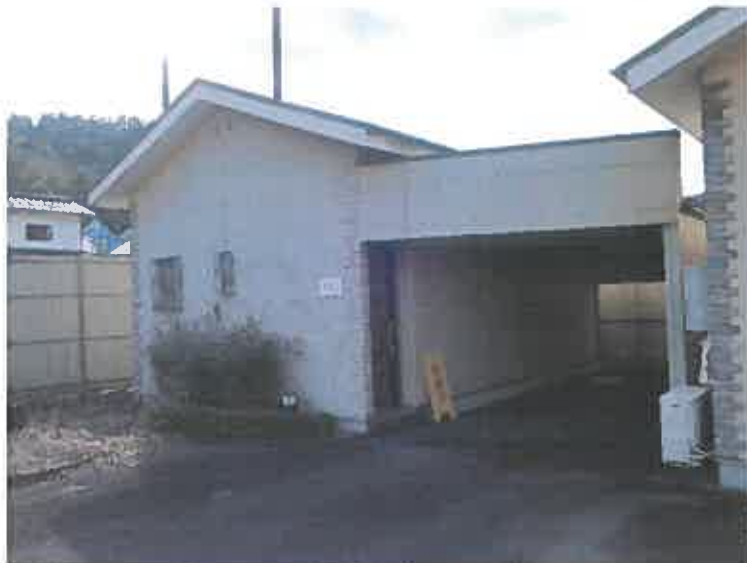
写真49 物件5建物附属建物符号5（111号室）
