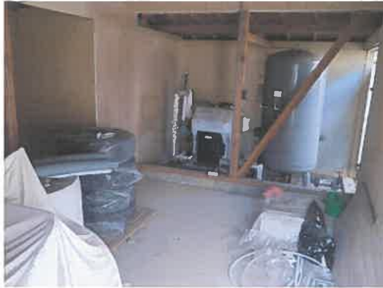
写真 8 2 物件 5 建物附属建物符号 1 1 (機械室)
