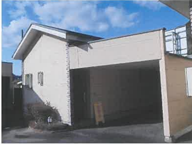
写真76 物件5建物附属建物符号10(108号室)
