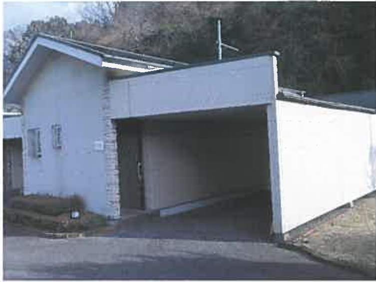
写真 2 8 物件 5 建物附属建物符号 2 (1 1 5 号室)
