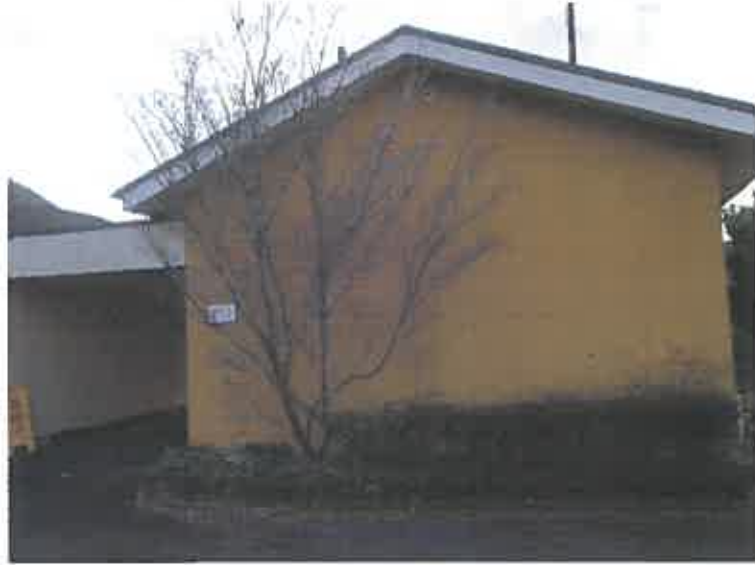
写真40 物件5建物附属建物符号4 (112号室)
