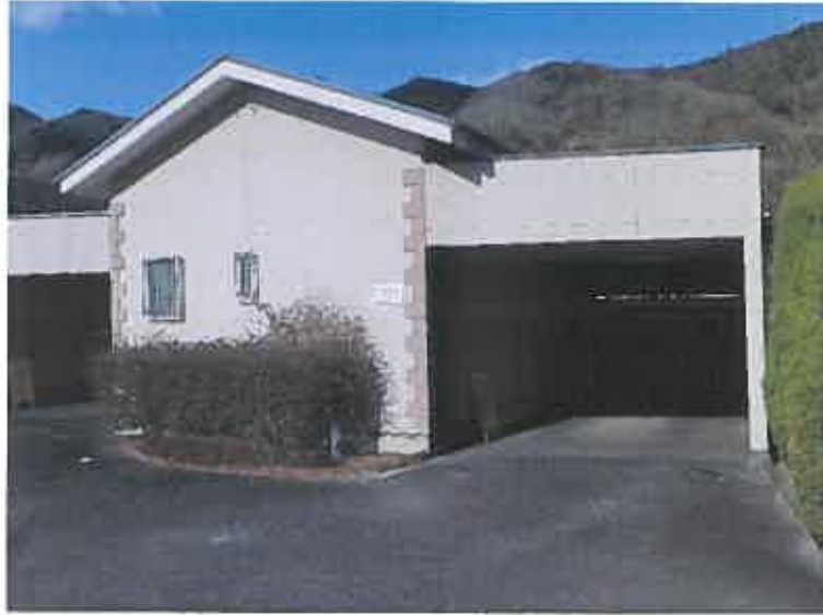
写真94 物件5建物附属建物符号14 (101号室)
