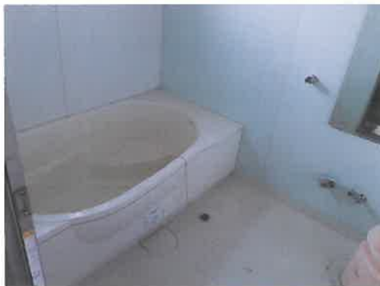
写真5 4 物件5建物附属建物符号5 (1 1 1 号室)
