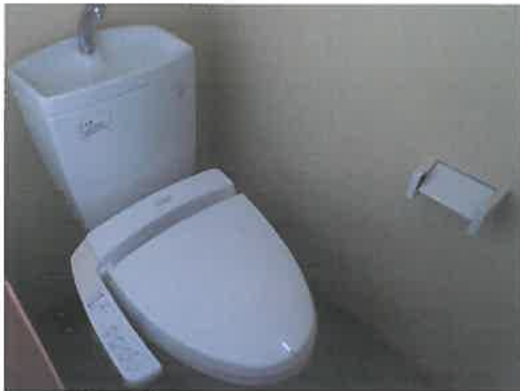
写真68 物件5建物附属建物符号8 (106号室)
