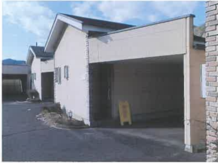
写真70 物件5建物附属建物符号9 (107号室)
