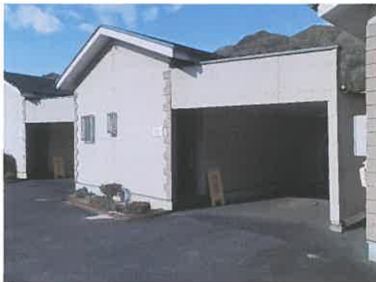
写真89 物件5建物附属建物符号13(102号室)
