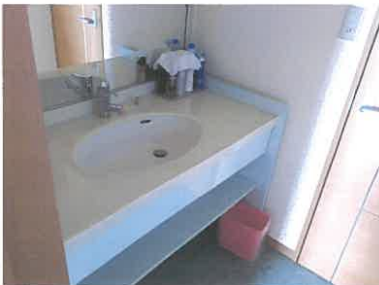
写真57 物件5建物附属建物符号6 (110号室)
