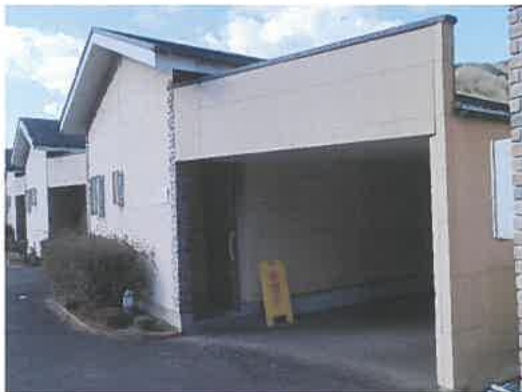
写真6 5 物件5建物附属建物符号8 (106号室)
