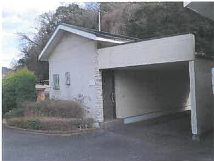
写真20 物件5建物附属建物符号1（116号室）
