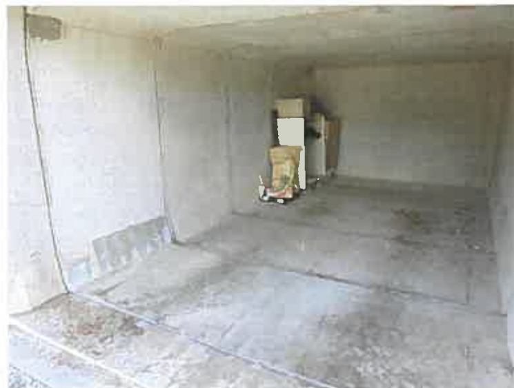
写真12 (本件建物 (附属建物) 内)
