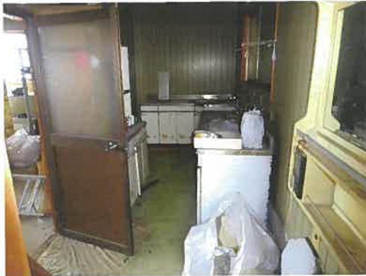
写真 2 2 (本件建物 (附属建物) 1 階)
