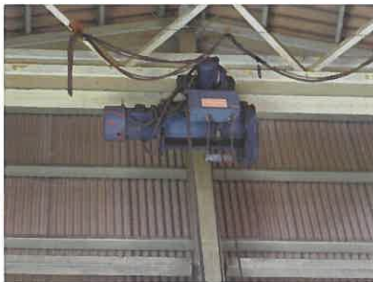
写真 1 7 (本件建物内 北側付近にある天井クレーン)
