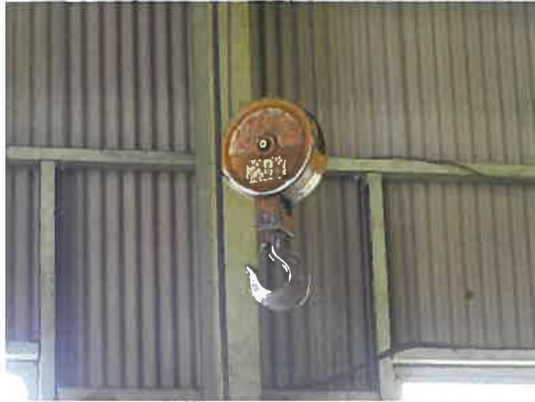
写真 1 6 (本件建物内 北側付近にある天井クレーン)
