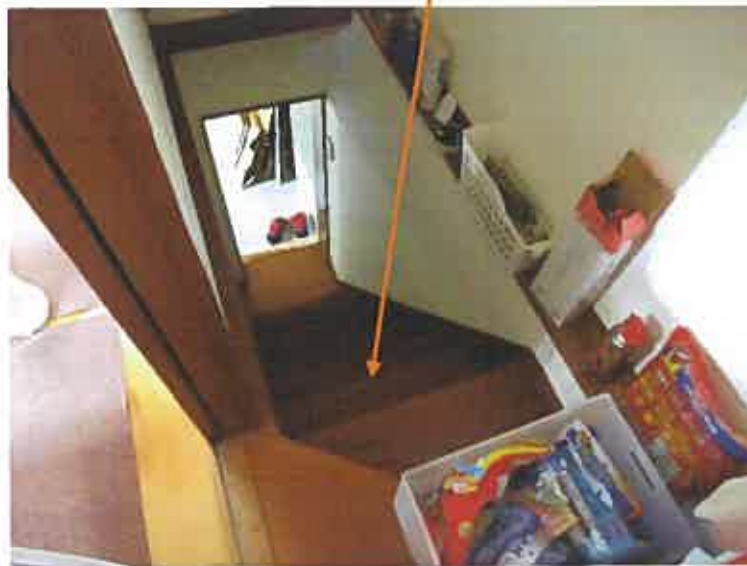
写真11 (本件建物 1階) 床下物置部分へ通じる階段
