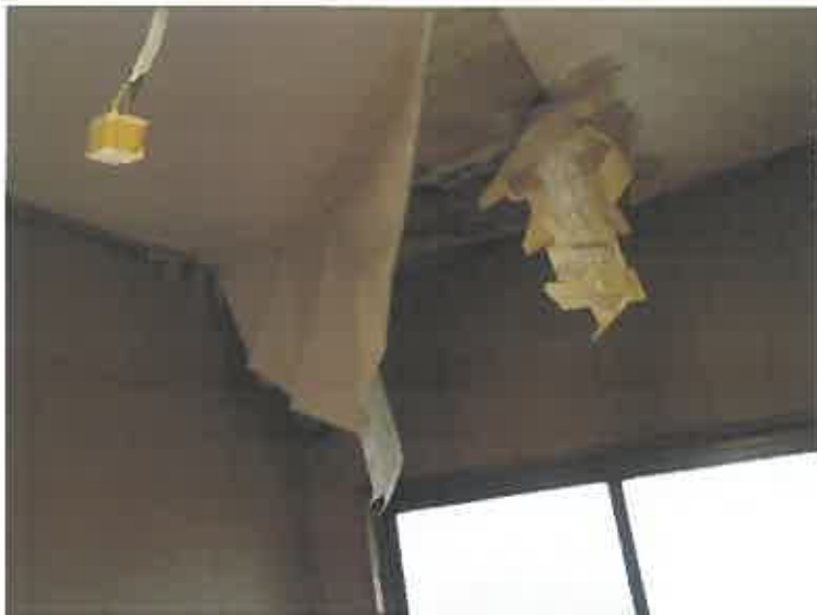
写真9 雨漏り箇所
