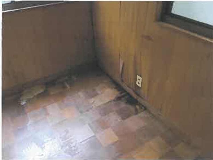
写真8 雨漏り箇所
