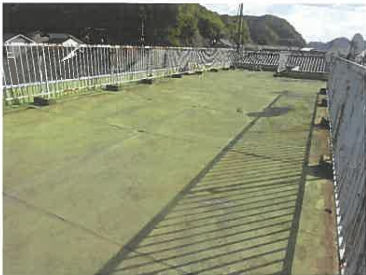
写真 3 9 (本件建物 屋上)
