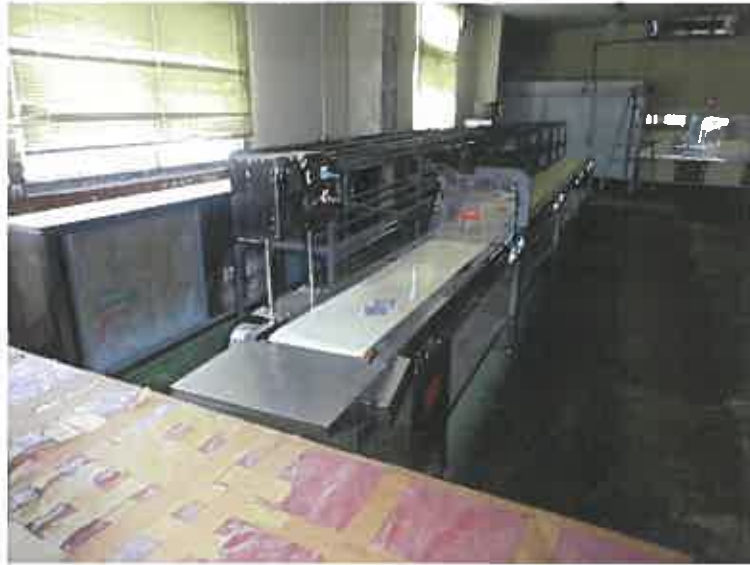
写真４３（本件建物内にある写真１１、１２のコンベアー）
