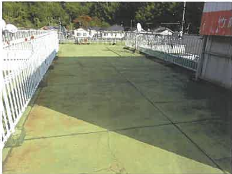
写真 3 8 (本件建物 屋上)
