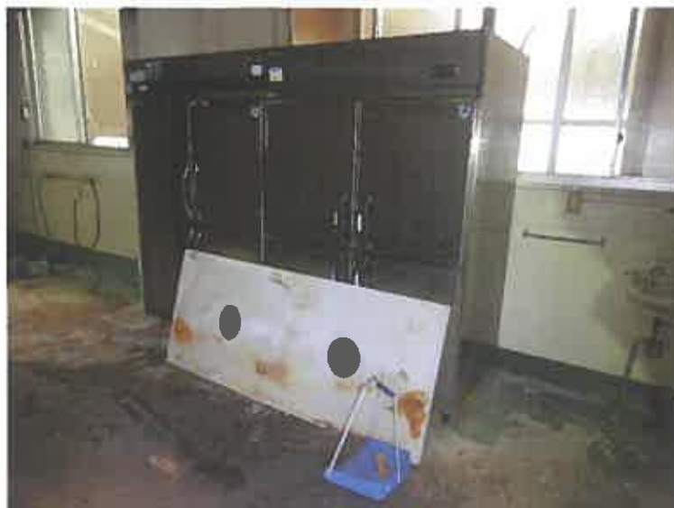
写真５１（本件建物内にある写真１７、１８の冷蔵庫）
