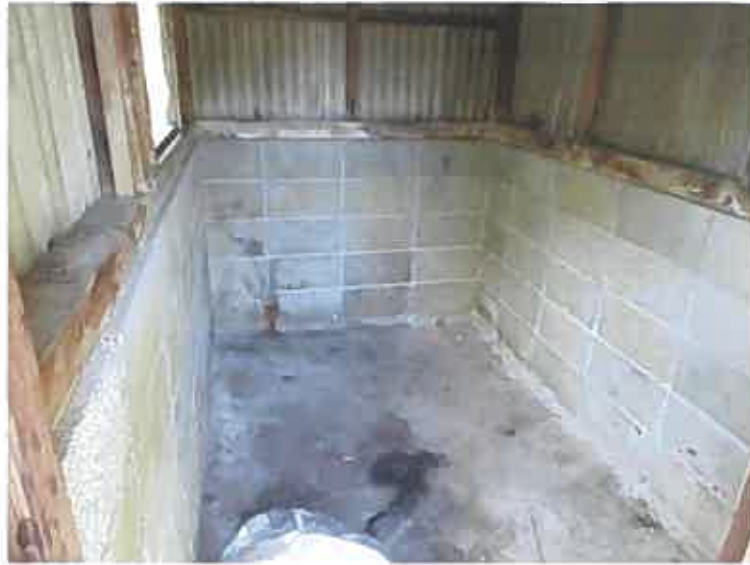
写真40 (未登記附属建物内)
