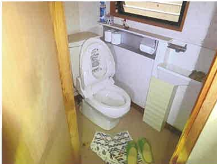
写真 2 6 (物件 2 の建物 (主建物) 1 階)
