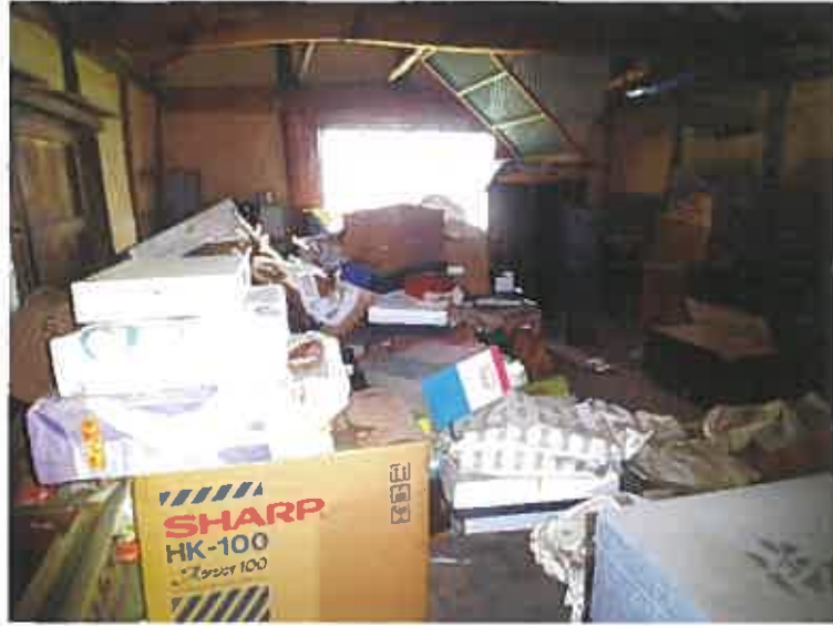
写真 3 2 (物件 2 の建物 (主建物) 2 階)
