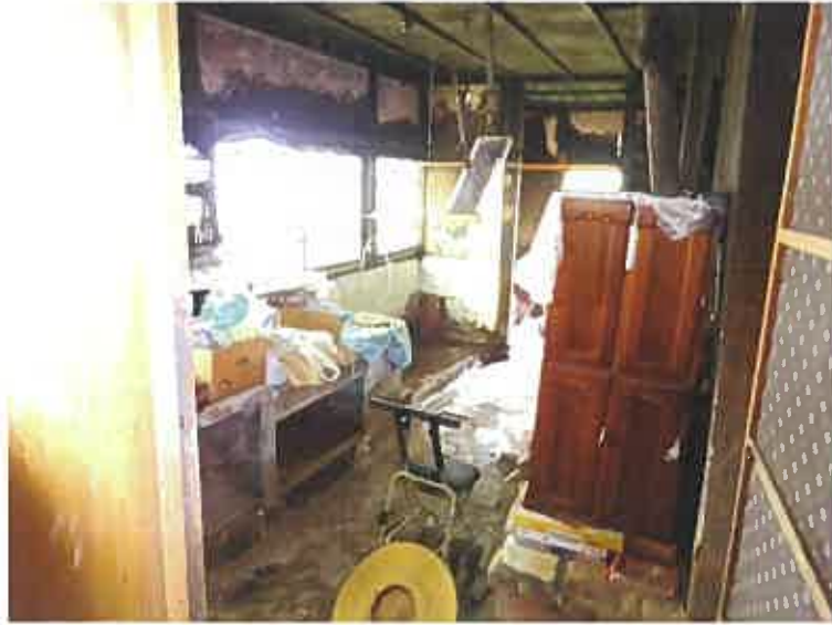
写真29 (物件2の建物(主建物) 1階)
