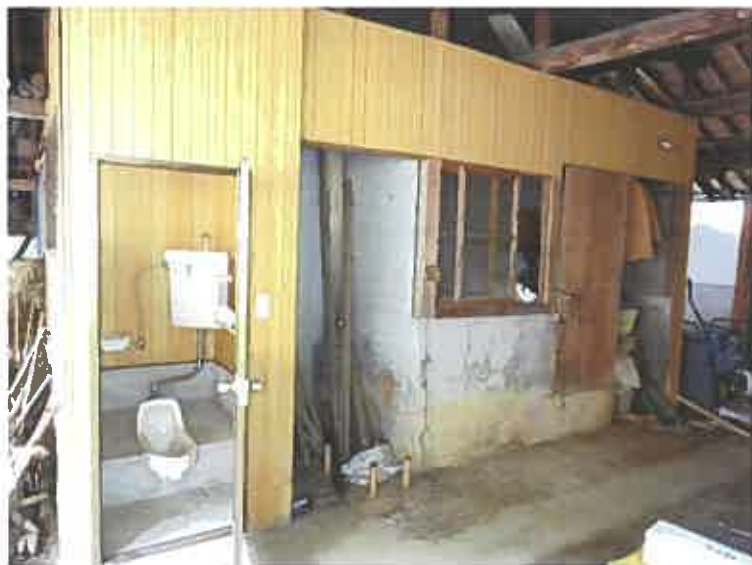
写真 3 4 (物件 2 の建物 (附属建物) 1 階付近)
