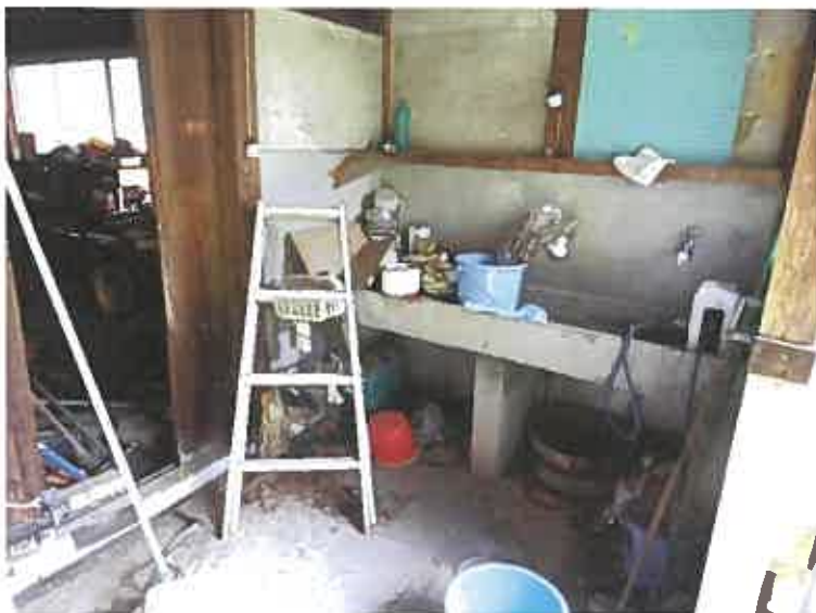
写真 3 7 (物件 2 の建物 (附属建物) 1 階付近)
