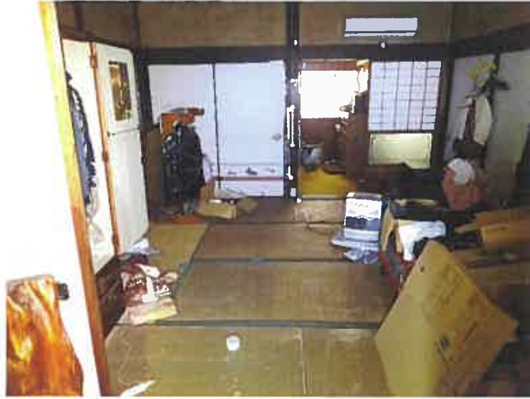
写真 2 3 (物件 2 の建物 (主建物) 1 階)
