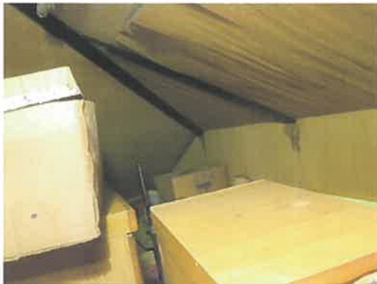
写真3 2 物件8建物（屋根裏収納内部の様子）
