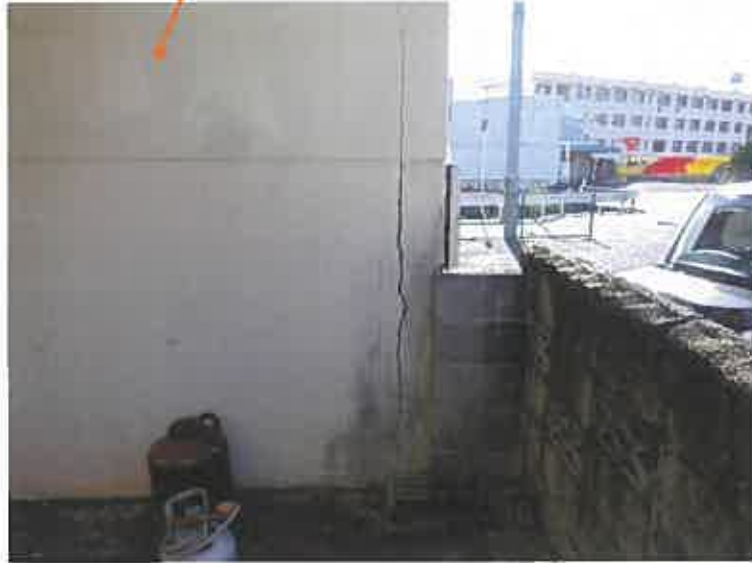
写真13 物件3の建物（主建物）
