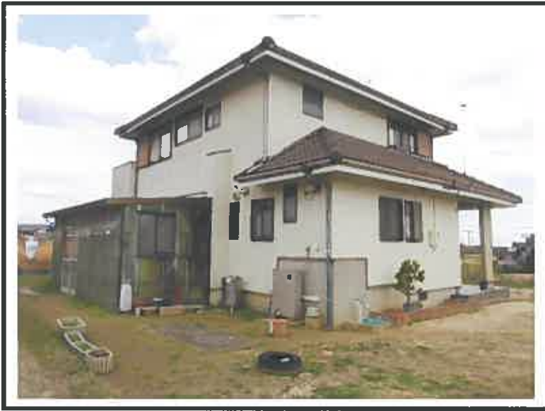
④ 物件3建物 近景
