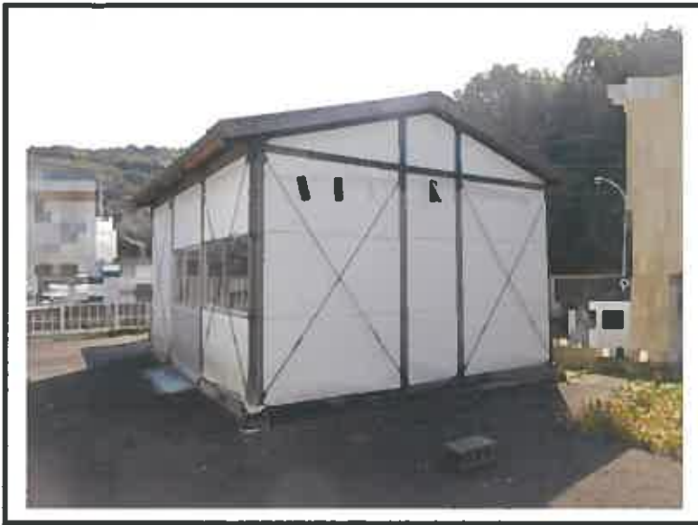
⑦ 未登記附属建物 A 近景
