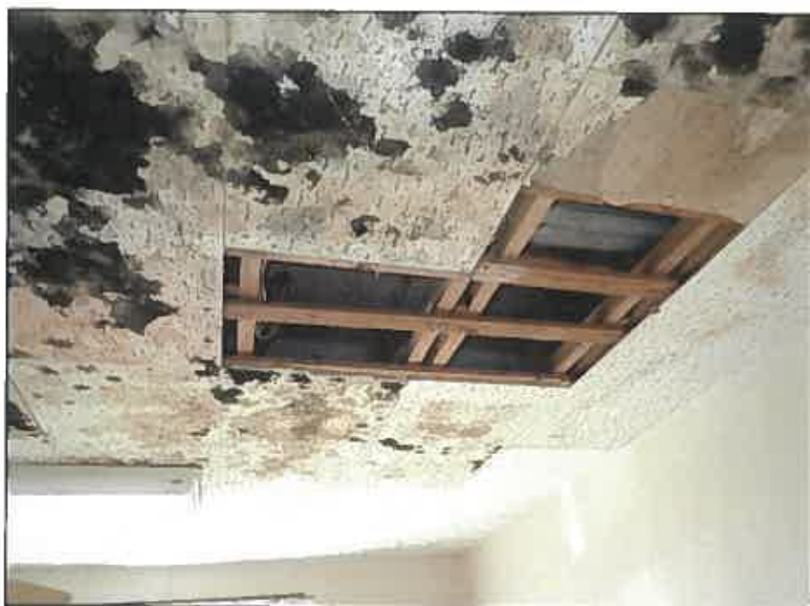
③ 101号室の天井の状況
