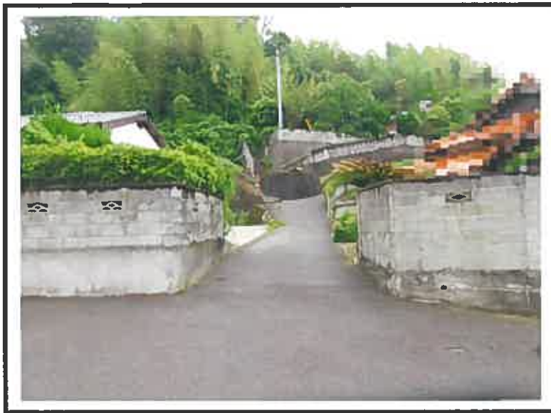
④ 南東側通路の状況
