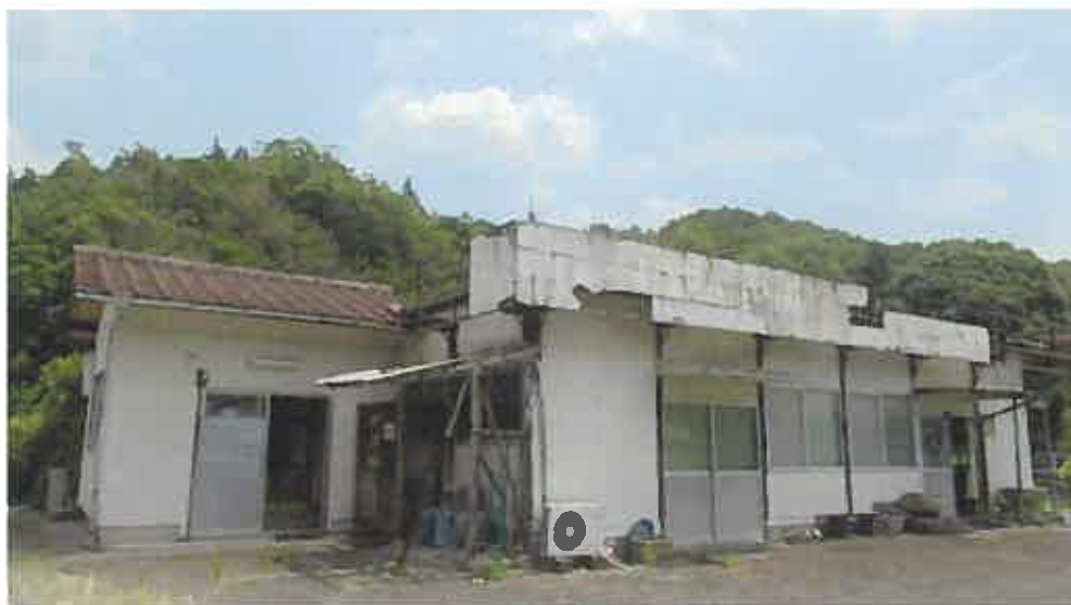
資料 1 本件建物 の外観
