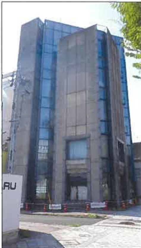
写真1 本件建物の外観
