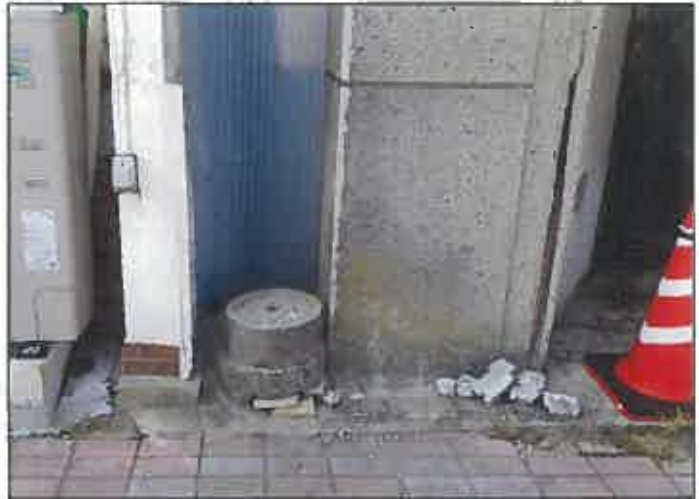
写真2 剥離した外壁の一部が落下した形跡がある状況
