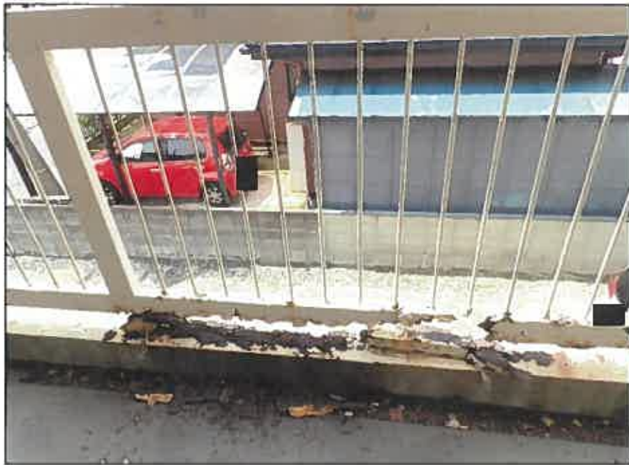
④ 物件9 ベランダの状況
