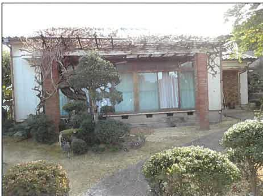
① 物件4 主である建物
