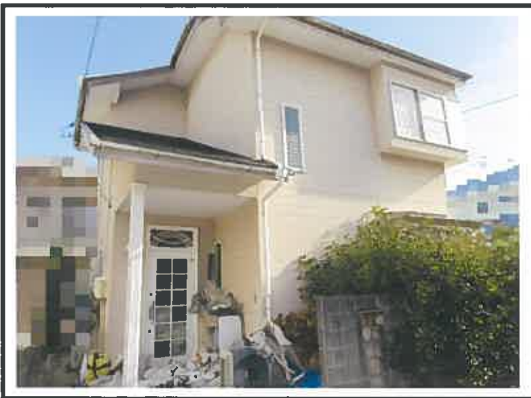
⑤ 物件2 主である建物 近景
