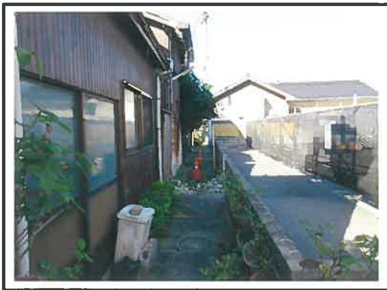
⑧ 背面の通路の状況
