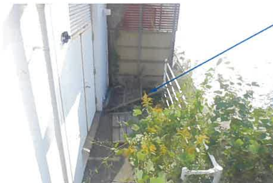
エアコン室外機跡 (地下1階)
