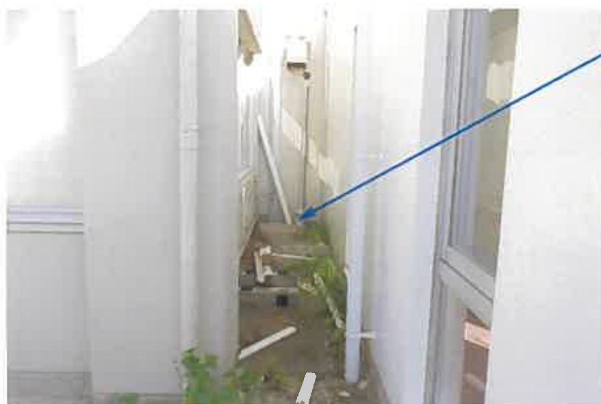
エアコン室外機用 コンクリートベース (3台分)
