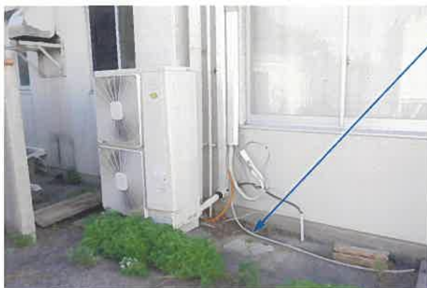
エアコン室外機跡
