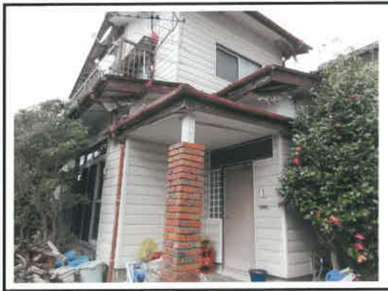
④ 物件4建物 近景
