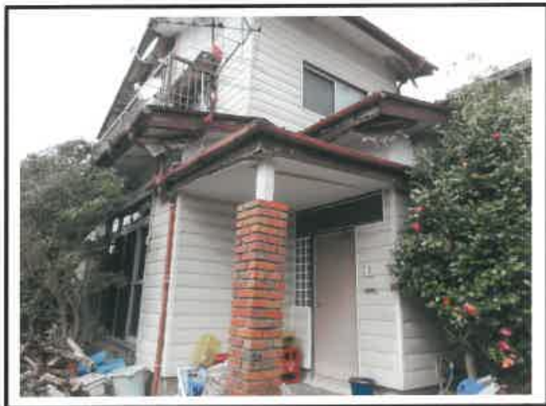
④ 物件4建物 近景
