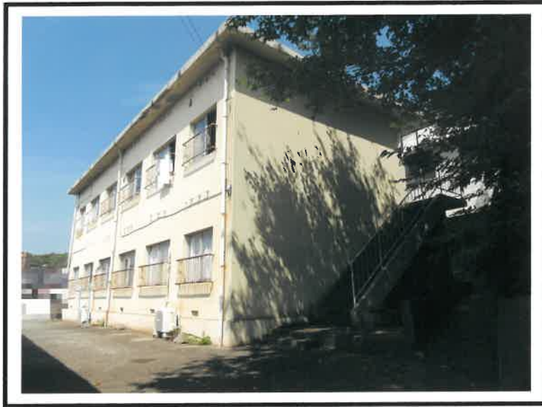
④ 物件2建物 近景
