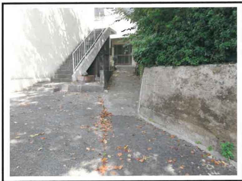
⑧ 東側市道の状況
