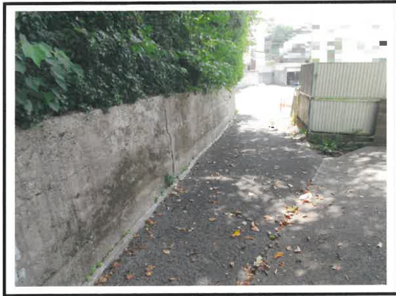
⑦ 東側市道の状況
