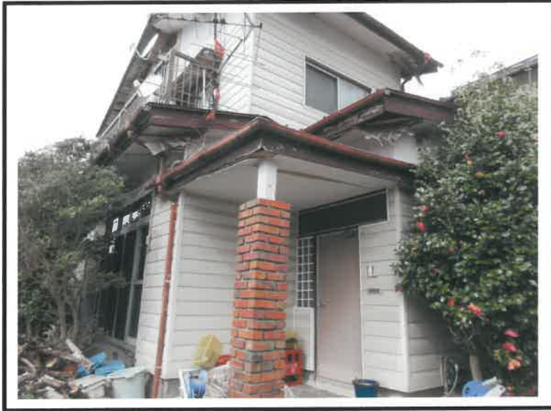
④ 物件4建物 近景
