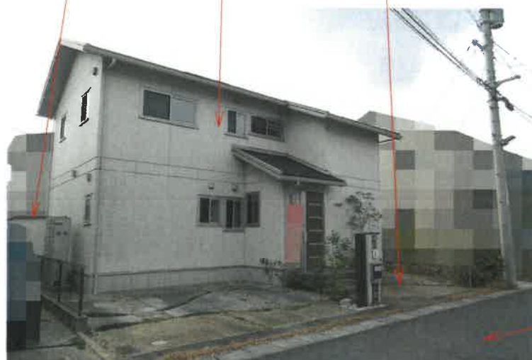
写真1 簡易物置 物件2建物 物件1土地
