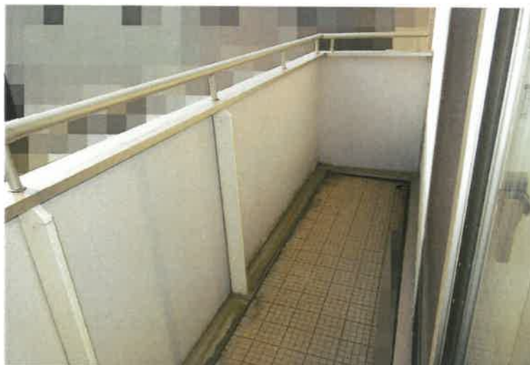
写真18 2階バルコニー
