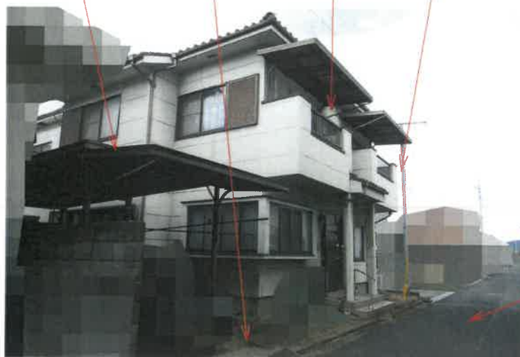
写真1 カポート 物件5 土地 物件6 建物 電柱
