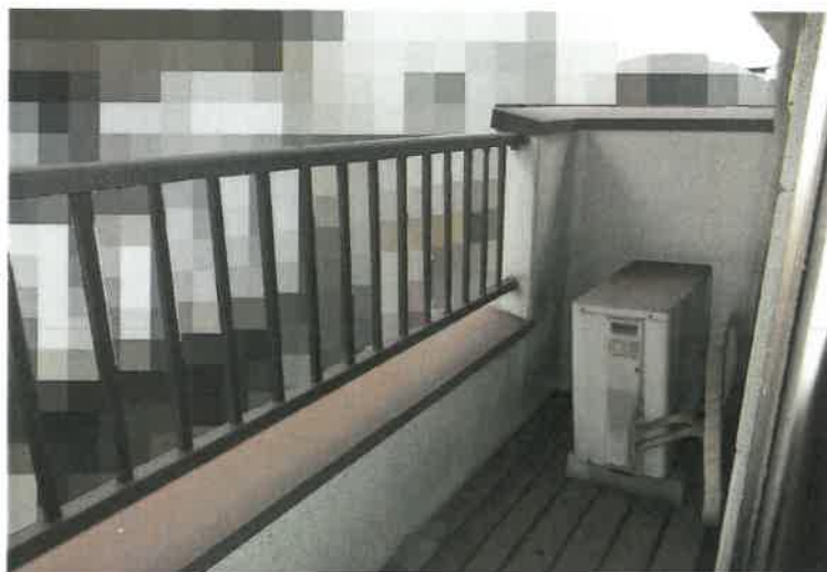
写真16 2階南東側バルコニー
