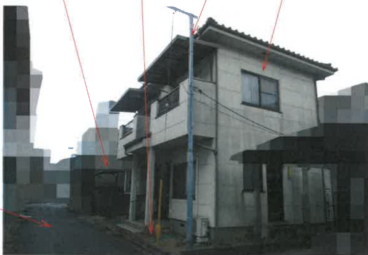
写真2 カポート 物件5 土地 電柱 物件6 建物
